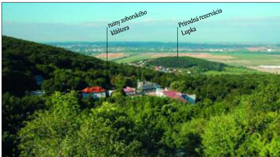
6. Súčasný pohľad na areál liečebného ústavu.
